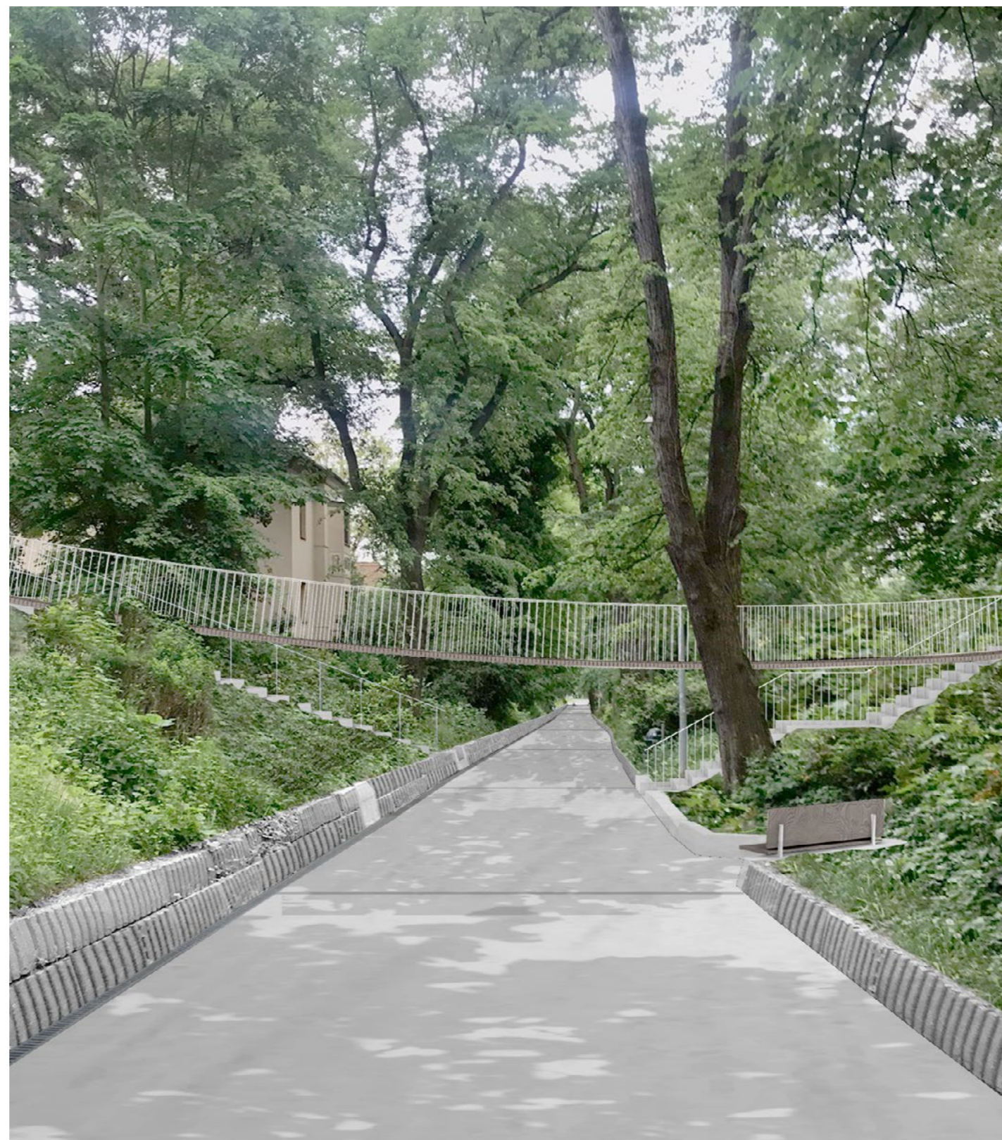
pohled alejí směrem k centru na nové přemostění
